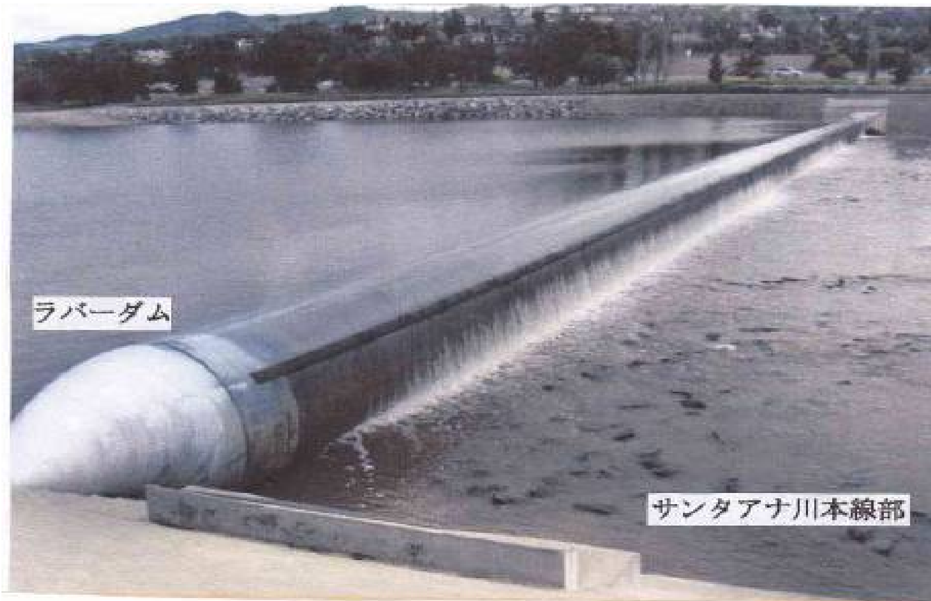
図-20 (7) サンタアナ川分水用のラバーダム
