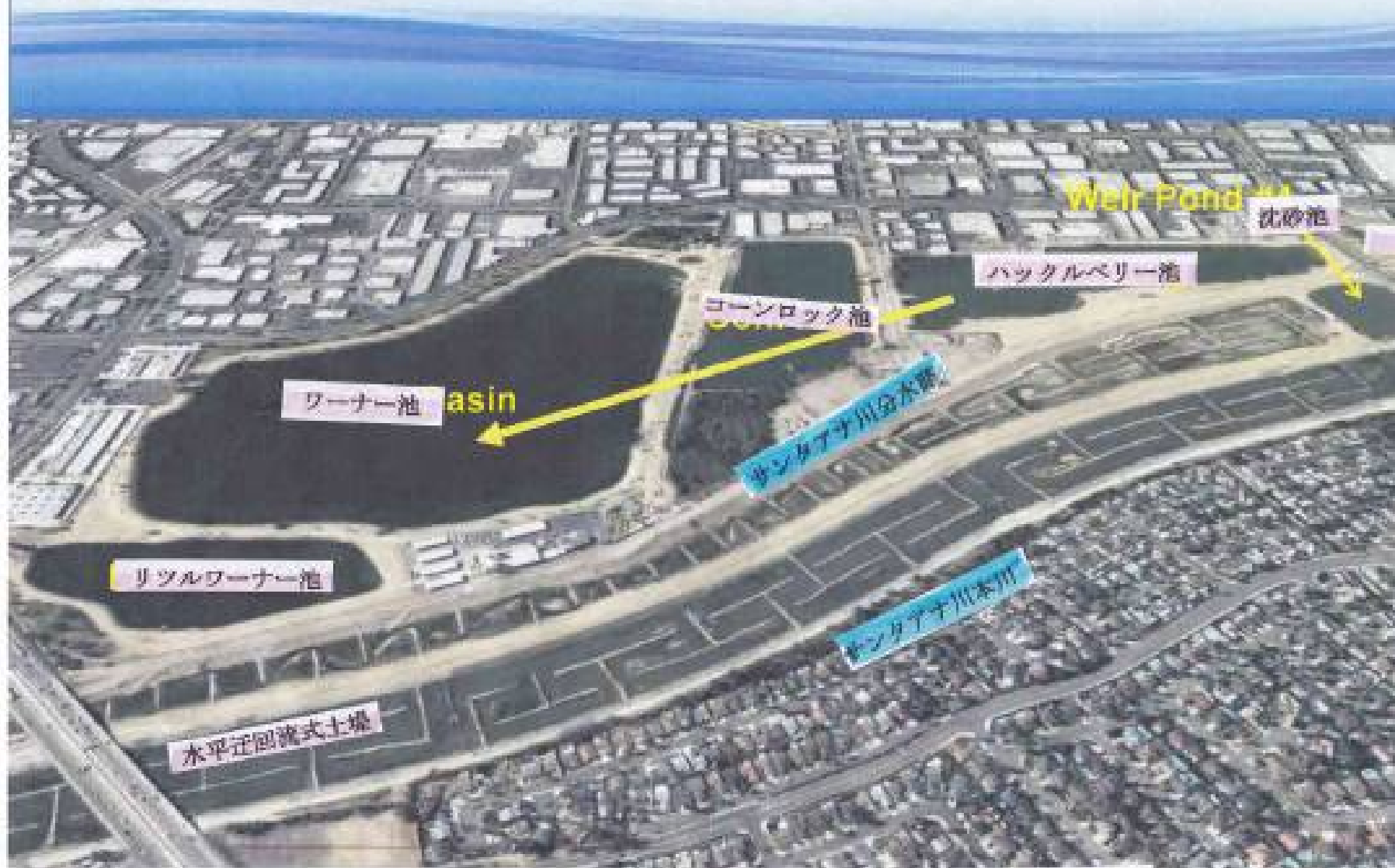
図-33: サンタアナ川河川敷の水平迂回流式浸透施設
