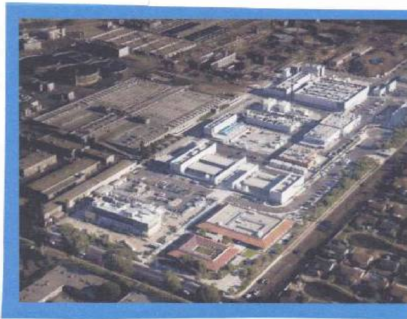
写真一5 オレンジ郡下水道組合及びオレンジ郡水道組合 施設の航空写真（左側：下水処理、右側：高度処理施設）
