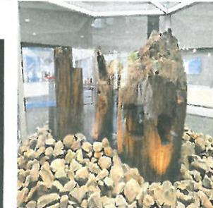
出雲大社大本殿を支えた9本の御柱の1本。真中の御柱(樹齢195年松直径1.3mを3本金輪で束ねた。推定高48m。鎌倉時代作)
